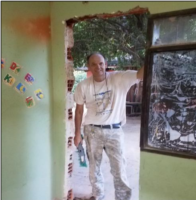
Der Durchbruch für die Türe
